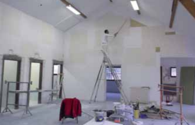
Réfection totale de l'intérieur du bâtiment
