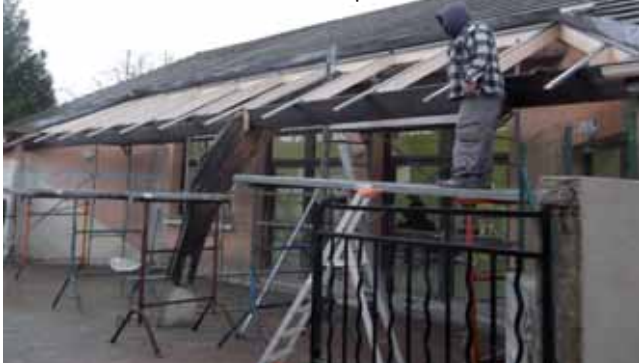
Réhabilitation de la structure Aquarelle
